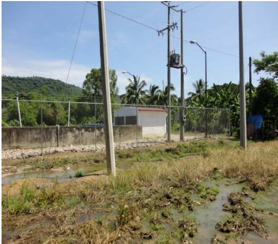
Fotografía 3 Infraestructura de drenaje en El Monteón
